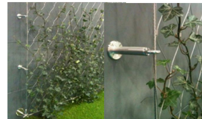
Muro com estrutura metálica para suporte de trapadeira com sistema de esticadores em aço inox tipo "JNF" e malha de aço.
