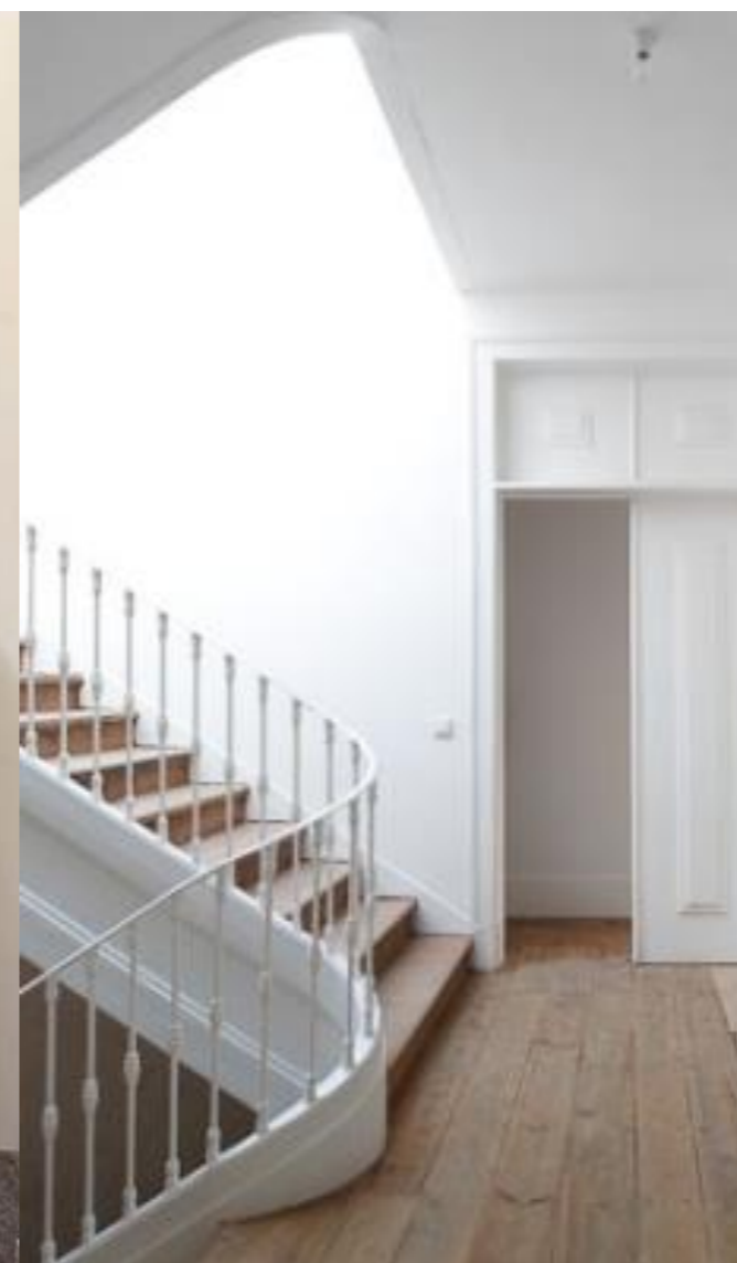
Imagem de referência da reabilitação da guarda de ferro e guarda chapim em madeira
