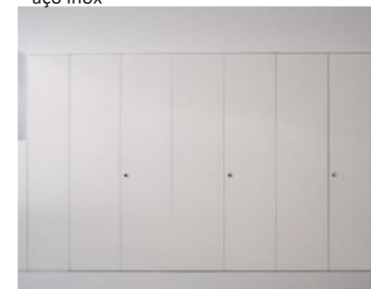
Armários técnicos embutidos na entrada compostos por painéis de MDF lacados na cor branco RAL 9010
