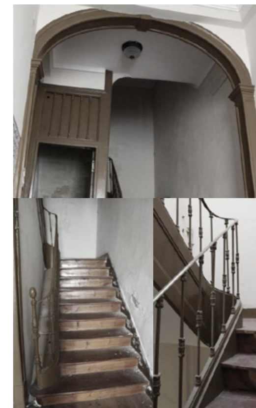
Elementos arquitectónicos existentes a preservar
