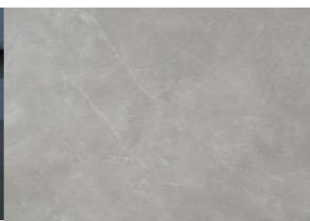
Muros com reboco estanhado com aplicação de verniz de impermeabilização incolor mate
